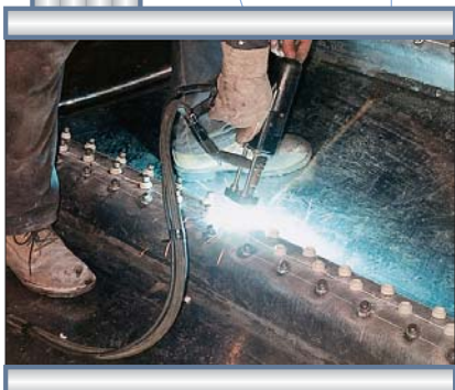
Pose de «Tuffstuds» à l'intérieur d'un tambour écorceur.
