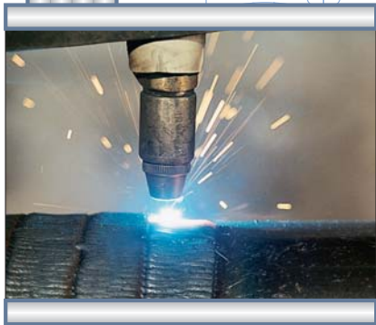
Procédé de rechargement par «Rapid arc».
